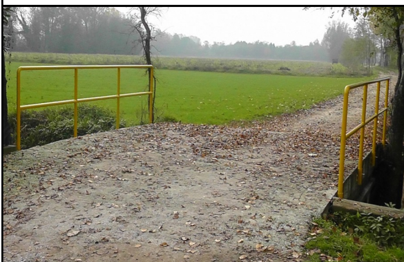
Nuova ringhiera sul ponte della Val di Cò
